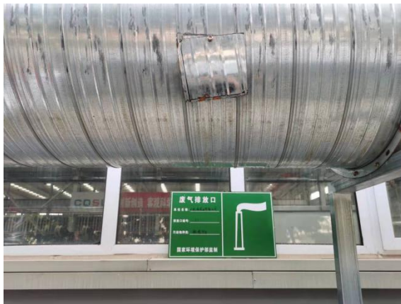
图 7 废气排气筒及废气排口标识
