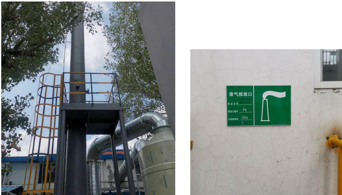
图 3 废气排气筒及废气排口标识
